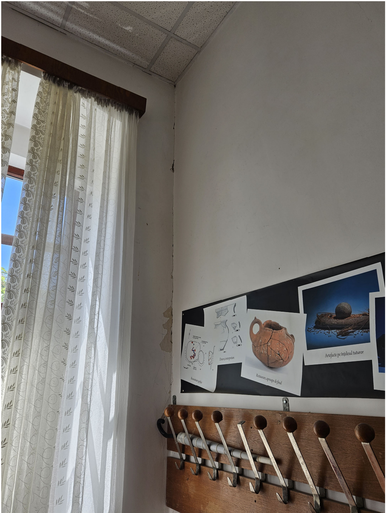
Interior, parter, Muzeografi – desprindere a zidului perpendicular pe fațada laterală dreapta – fațada Sud – țesere necorespunzătoare a zidăriei.
