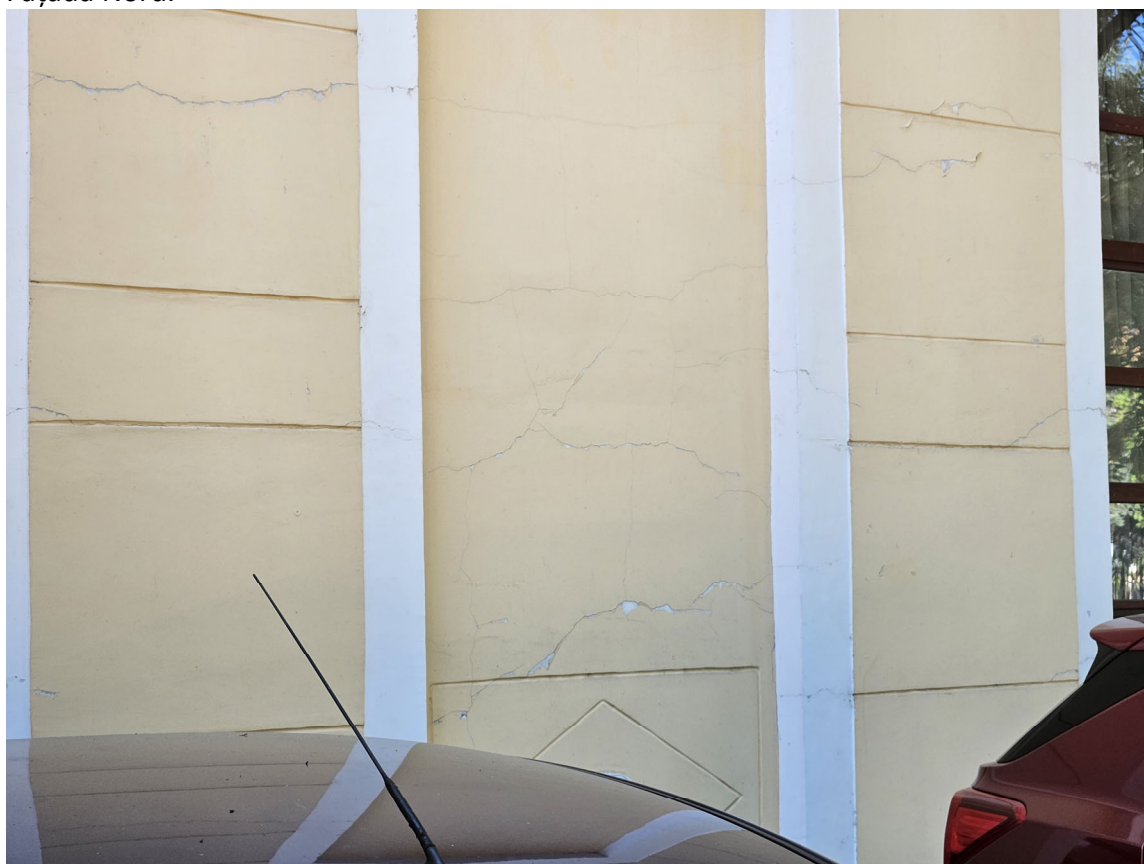
Fațada Nord. Detaliu fisurare în dreptul ferestrei zidite și în șpaleții învecinați.
