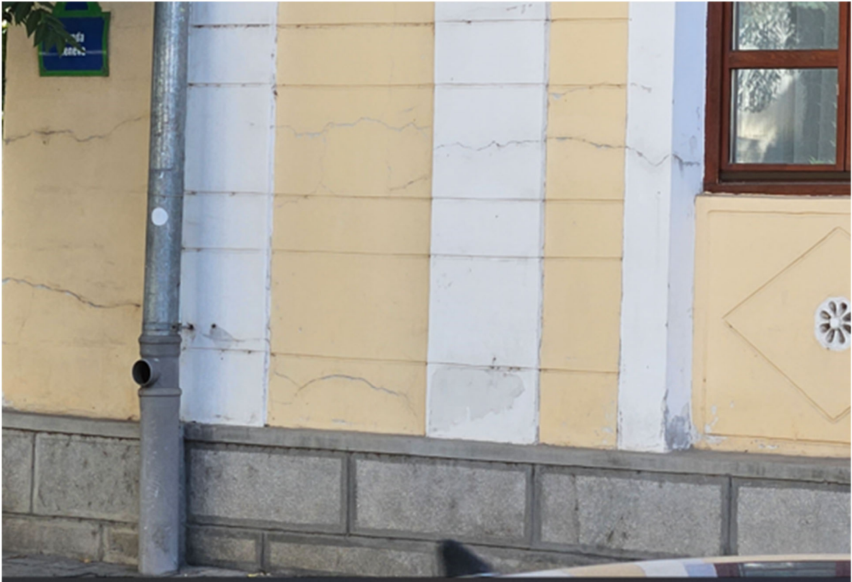
Fațada principală – Vest. Colț N-V, detaliu fisurare parter.
