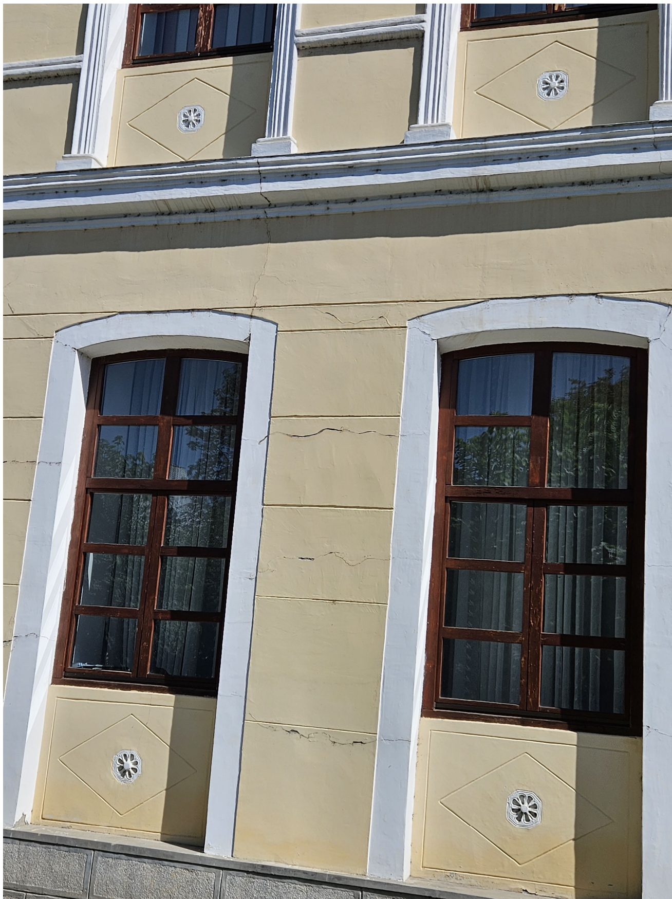
Fațada Sud – detaliu fisurare panouri între ferestre – parter.
