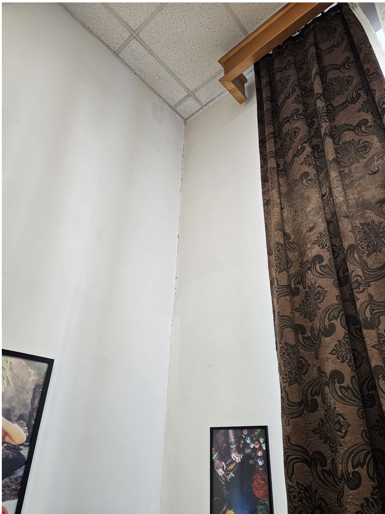
Interior, parter, Sala Studio – desprindere a zidului perpendicular pe fațada principală – țesere necorespunzătoare a zidăriei.
