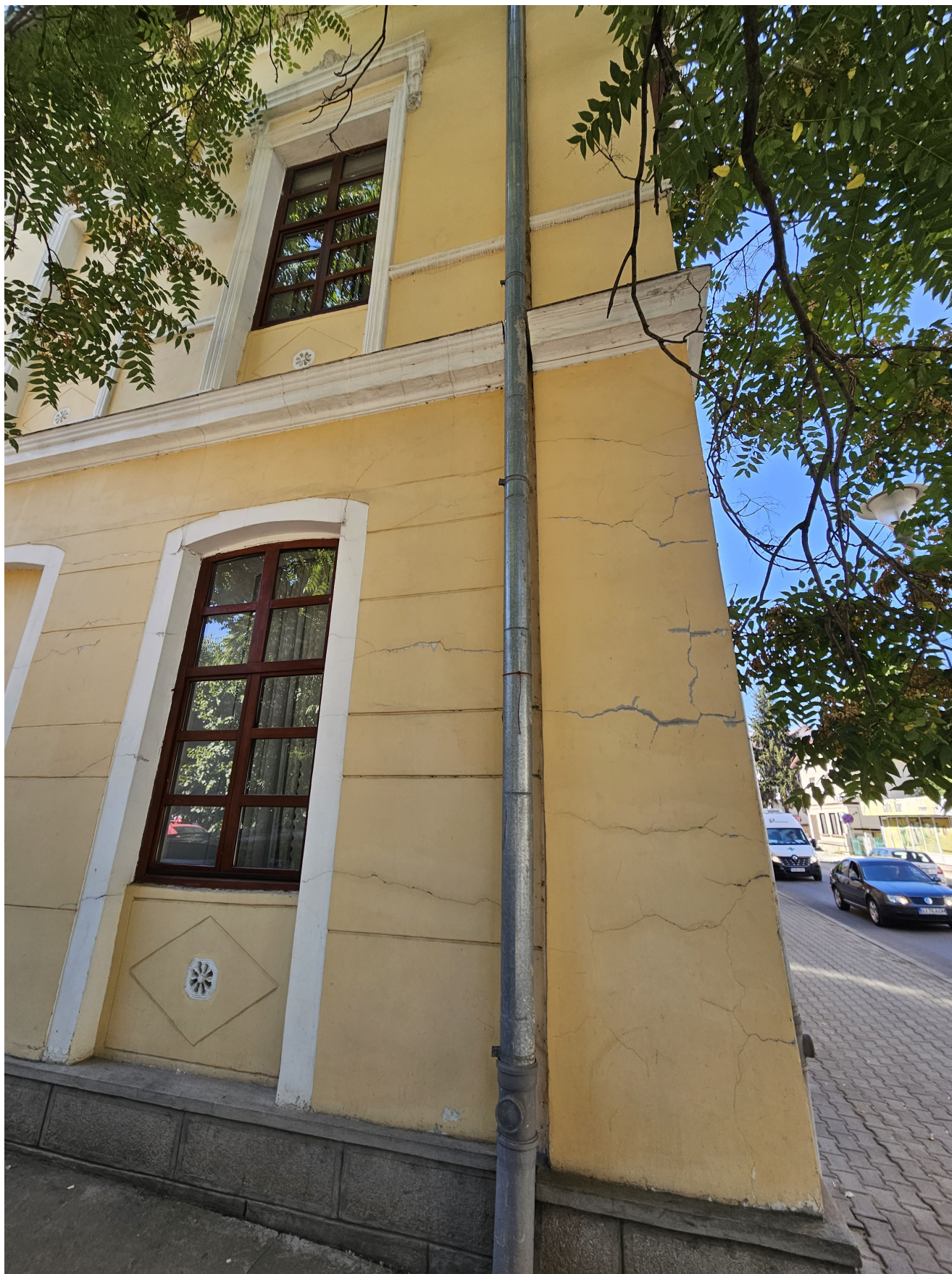
Fațada Nord – colț N-V. Detaliu fisurare parter + etaj.
