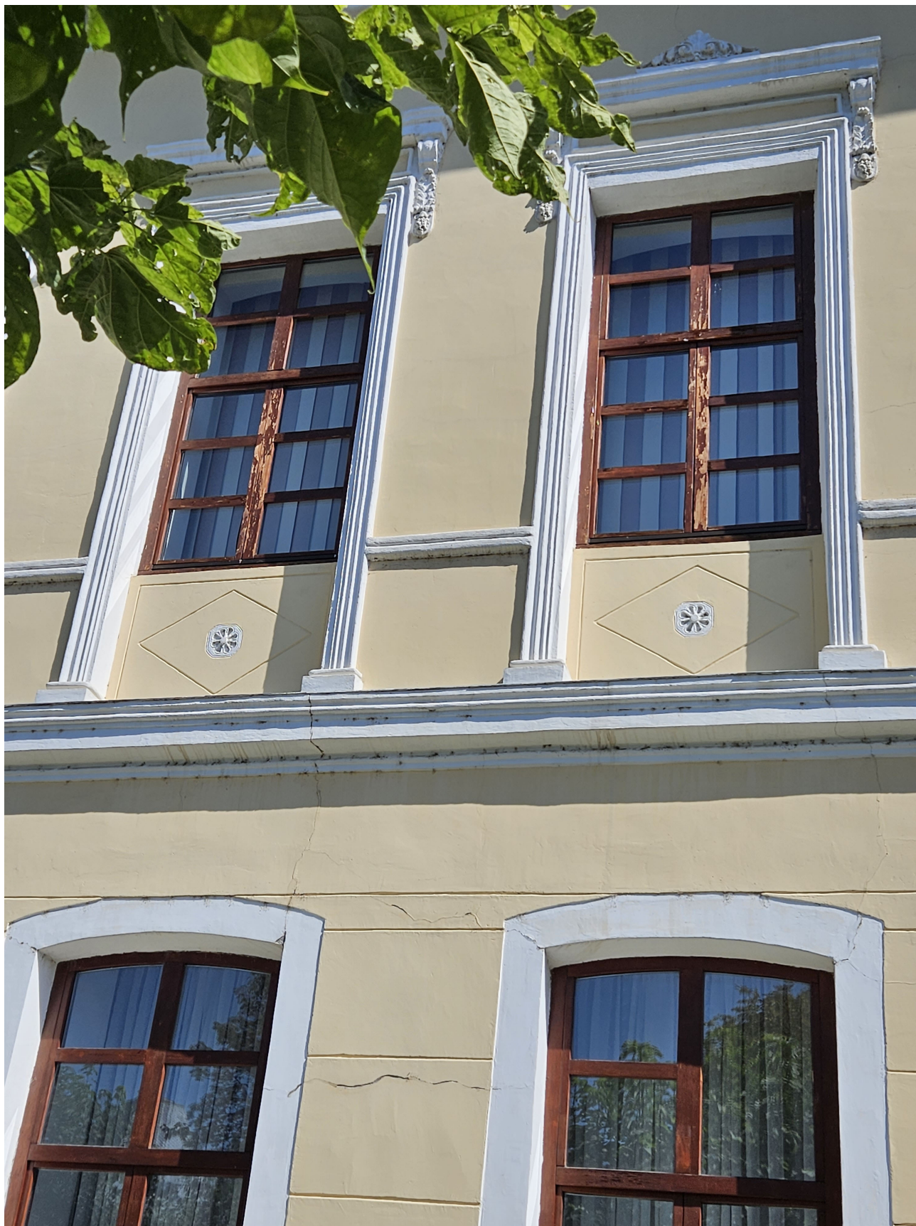
Fațada Sud – detaliu fisurare panouri între ferestre – etaj.
